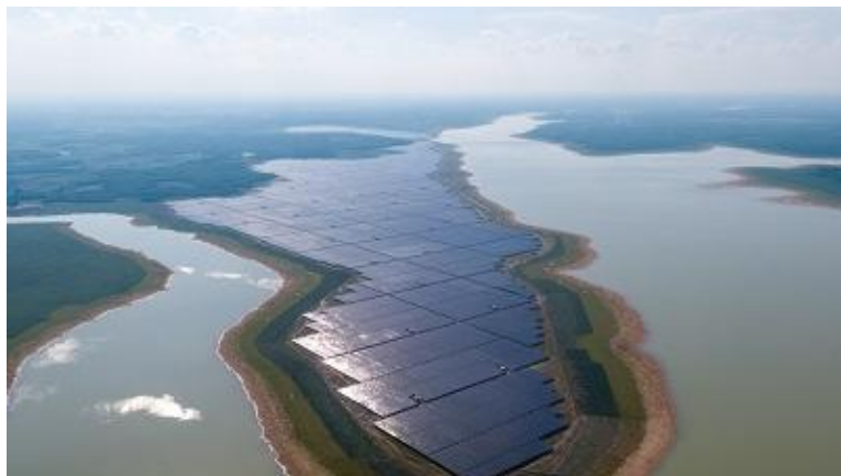
越南油汀太阳能电站
