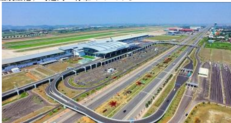
河内内排机场
