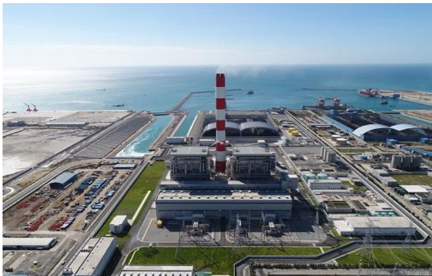
永新电厂一期
