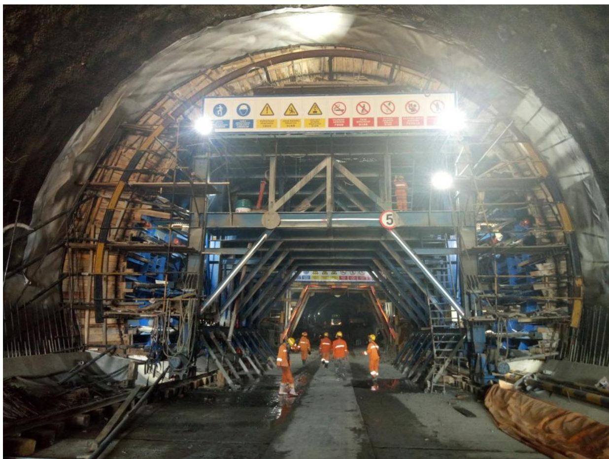
雅万高铁施工现场
