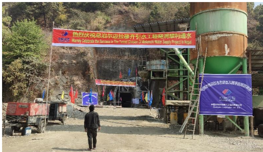
中国电建水电六局承建迈拉穆齐引水项目
