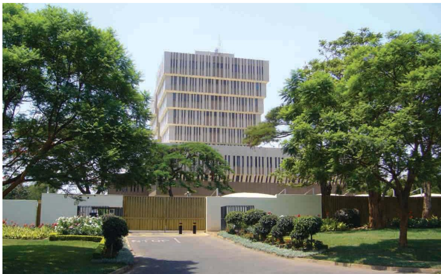
马拉维储备银行总部大楼
