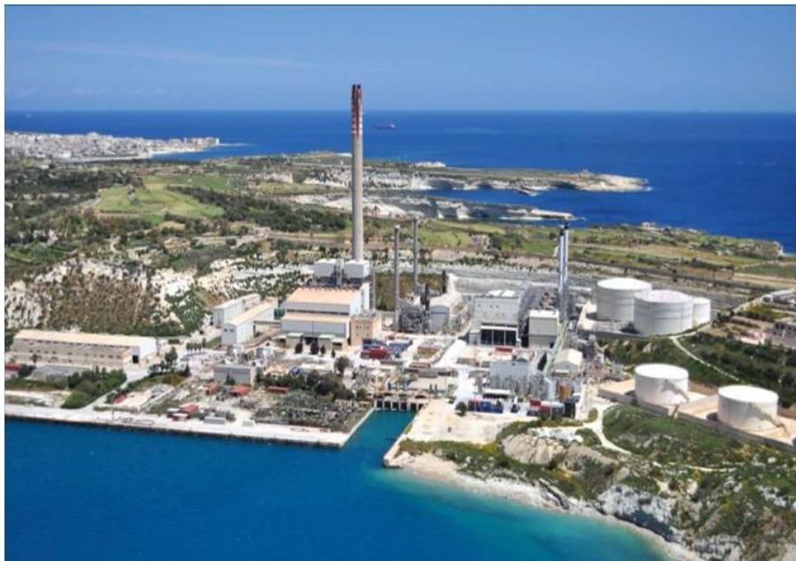
上海电力马耳他D3电厂
